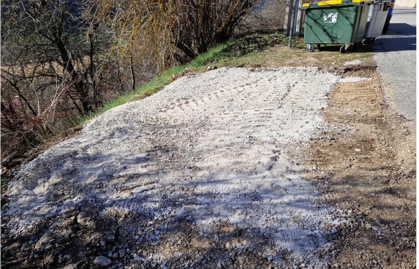
Une plate forme a été réalisée à l'emplacement des conteneurs poubelles, avec une barrière en bois afin qu'ils ne basculent plus en contre bas.
