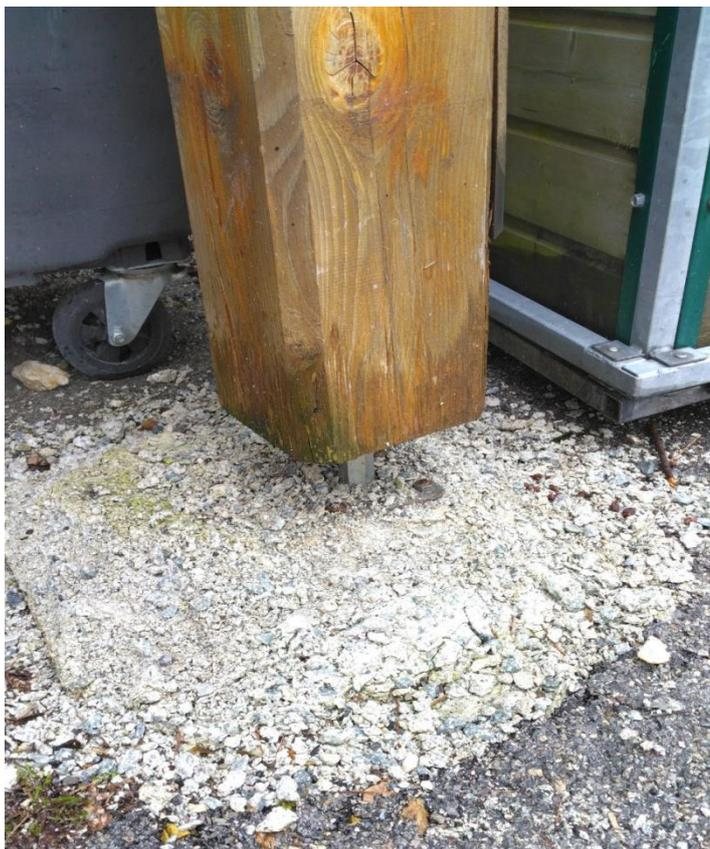
Avec les intempéries, pluie, neige, les piliers en bois se détériorent, ils ont été renforcés et surélevés par des socles en maçonnerie les isolent du sol
