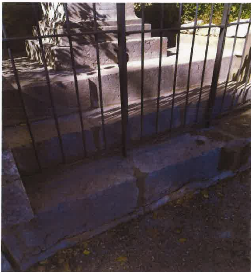
Travaux de maçonnerie pour refixer les marches de la mission, place du village
